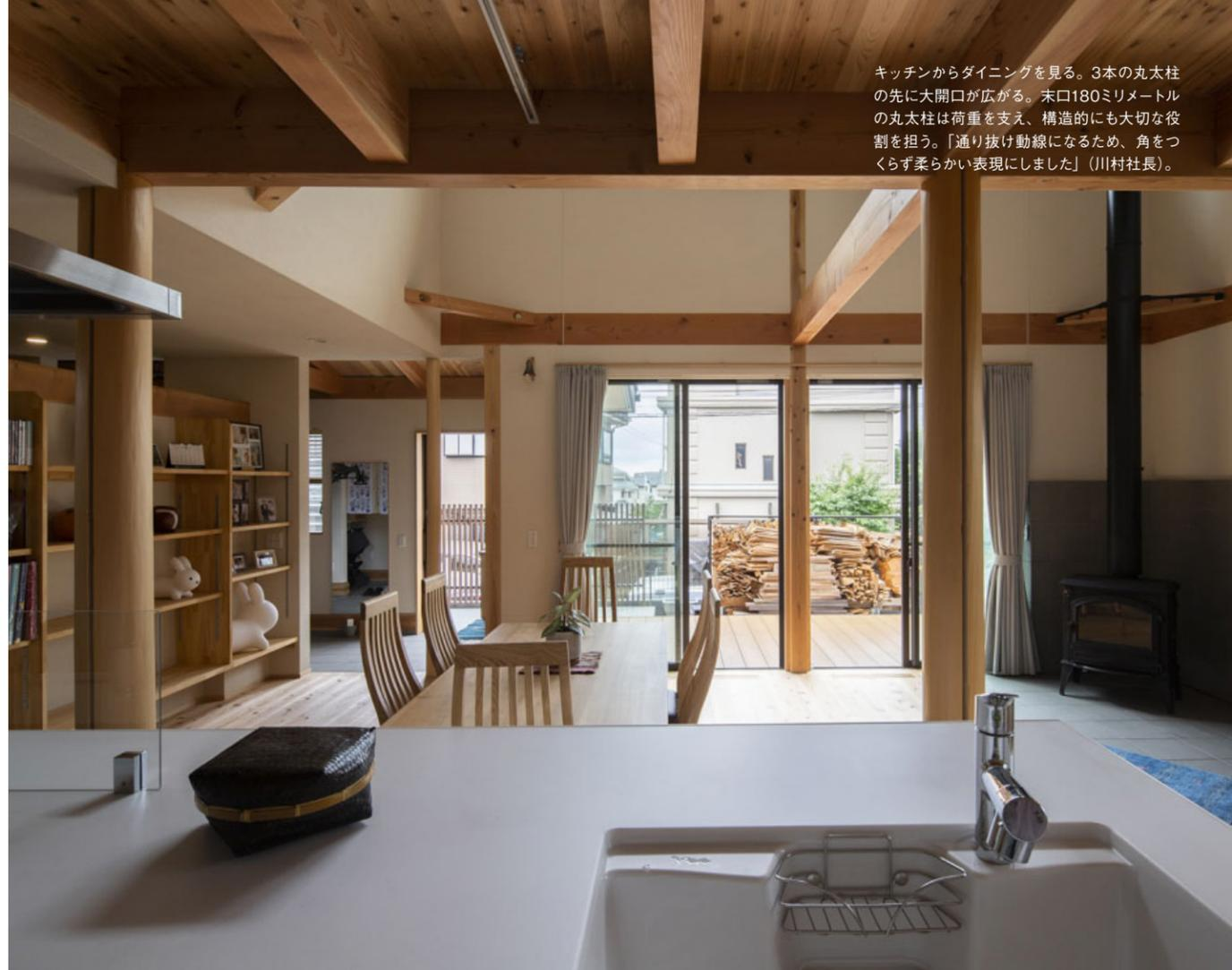
キッチンからダイニングを見る。3本の丸太柱の先に大開口が広がる。末口180ミリメートルの丸太柱は荷重を支え、構造的にも大切な役割を担う。「通り抜け動線になるため、角をつくらず柔らかな表現にしました」(川村社長)。
