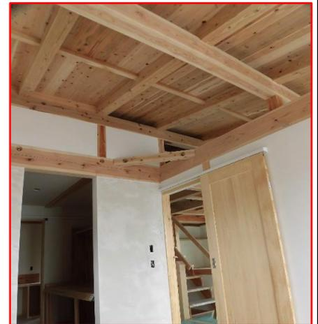
柱・梁・土台に大量の接着剤で貼り合わせた集成材は使わず産地の明らかな生産者から直接無垢の材を購入しています。壁天井にも接着剤を大量に使うビニールクロスは使わず調湿性に優れた珪藻土や漆喰等で塗り壁仕上げします。断熱材は断熱欠損の多いグラスウールや有害ガスを発生する発砲ウレタン等は使わず断熱性能に加え調湿性能にも優れたセルロースファイバーを圧密55Kで充填断熱します。家族の健康と地球に優しい家づくりのために
