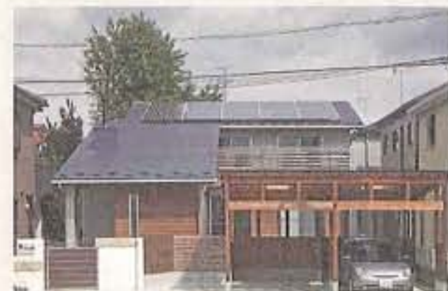
ソーラーパネルが設置された大屋根。
