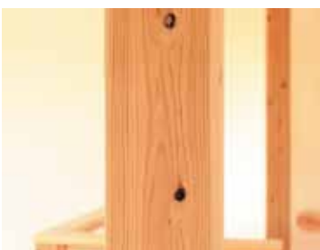
真壁工法を採用
